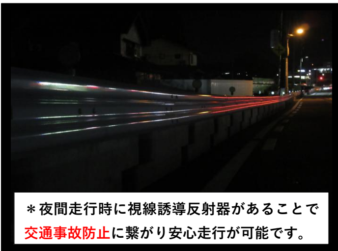
＊反射器貼付け「無し」のガードレール
